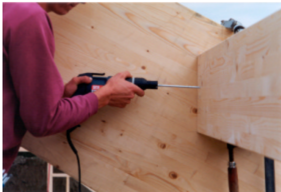
Fig. 8: collegamento della trave al palo
