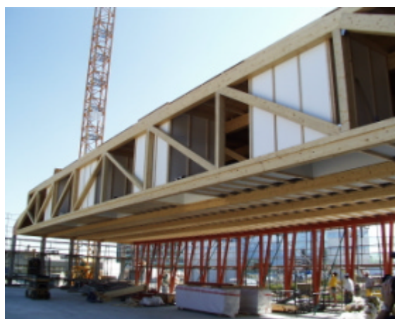
Fig. 13: traliccio di trave
