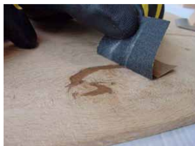
CARTEGGIARE O LEVIGARE LA SUPERFICIE RIPARATA E IL SUO INTORNO
