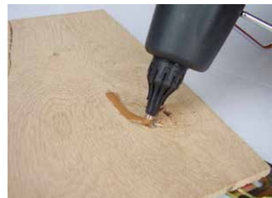
INIETTARE IL KNOT FILLER SOMMARIAMENTE SOPRA IL FORO DA RIPARARE
